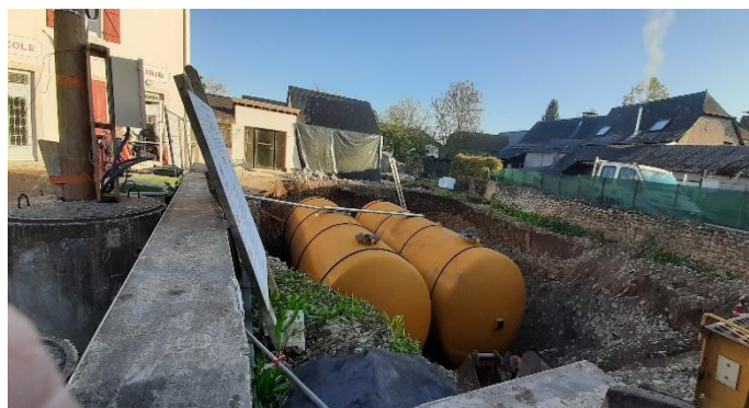
Après une réserve neuve, sécurisée, enterrée
